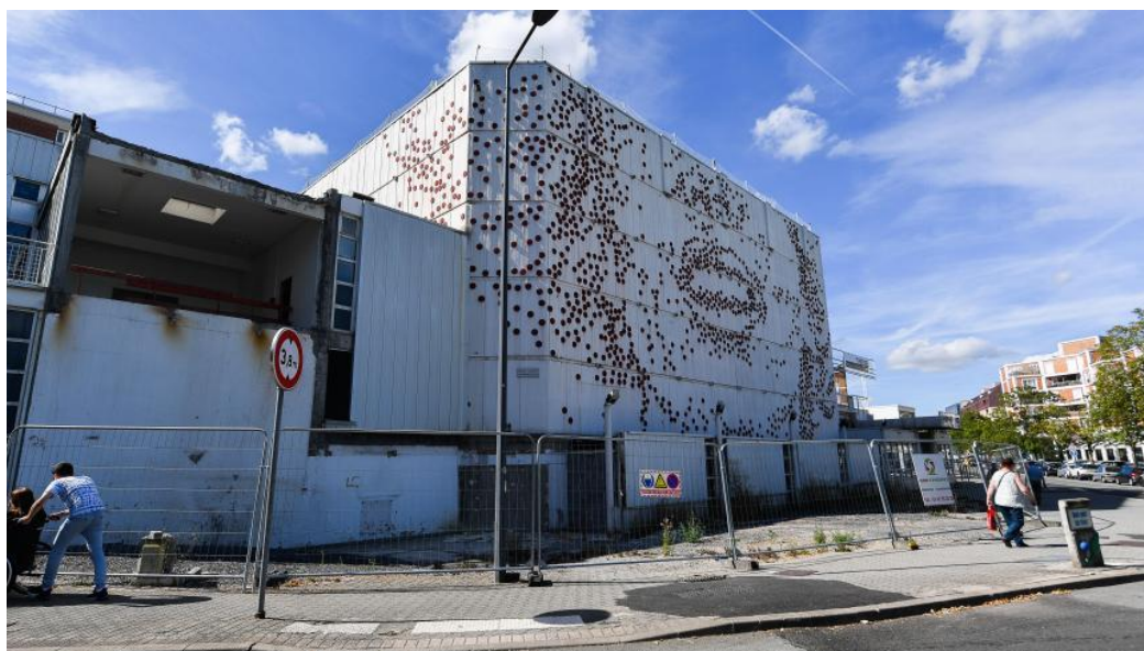
La Rose des Vents à Villeneuve-d'Ascq. PHOTO ZOULERAH NORDDINE - VDNPQR
