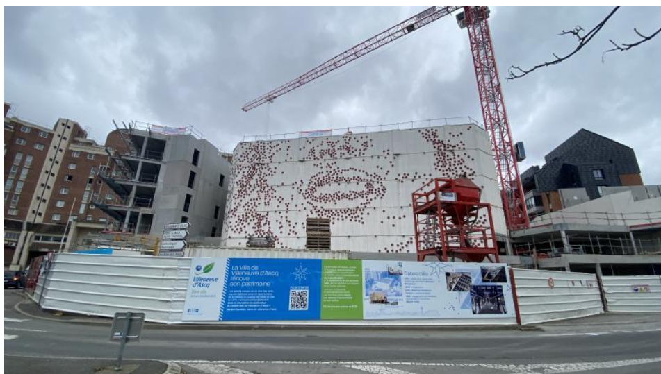
La Rose des Vents est en chantier pour encore un an.
