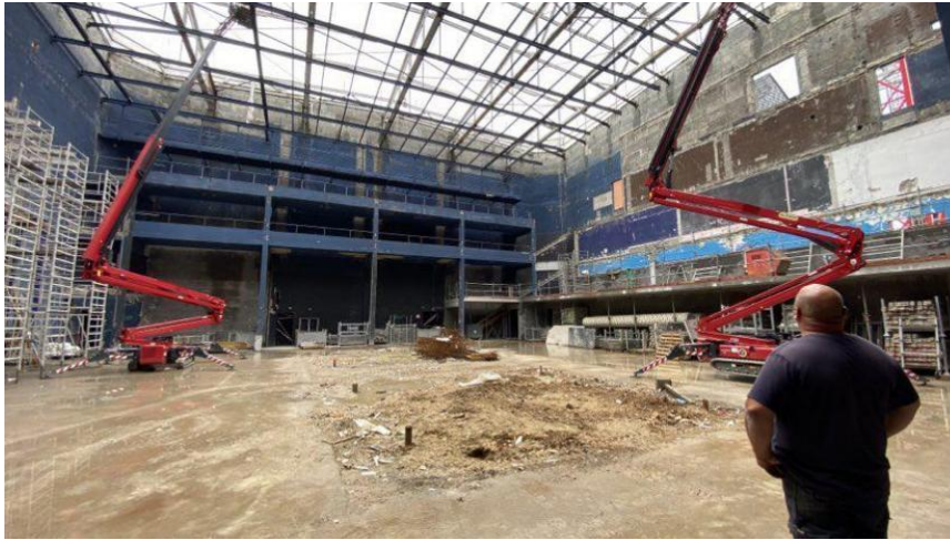
L'intérieur du «cube» : méconnaissable !
