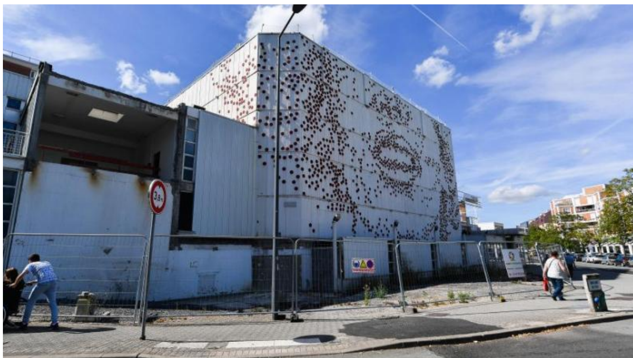
Le chantier de la Rose des Vents se poursuit et les relations entre la direction de la structure et la municipalité se sont apaisées. Photo Zoulerah Norddine
