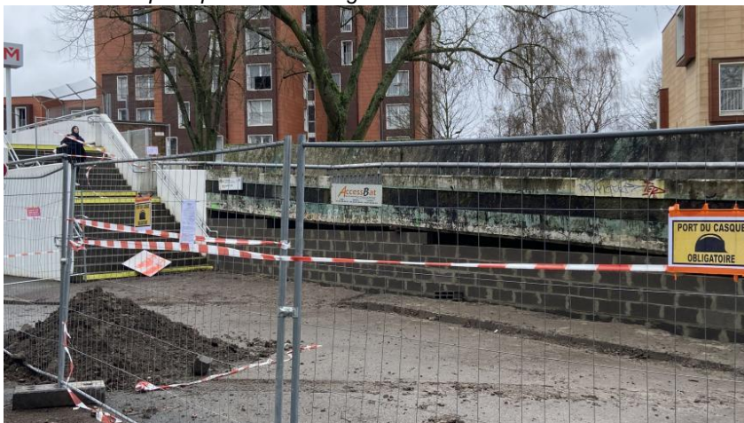
Les accès au métro pour les personnes à mobilité réduite seront rénovés et le bas des passerelles végétalisé. - LA VOIX
