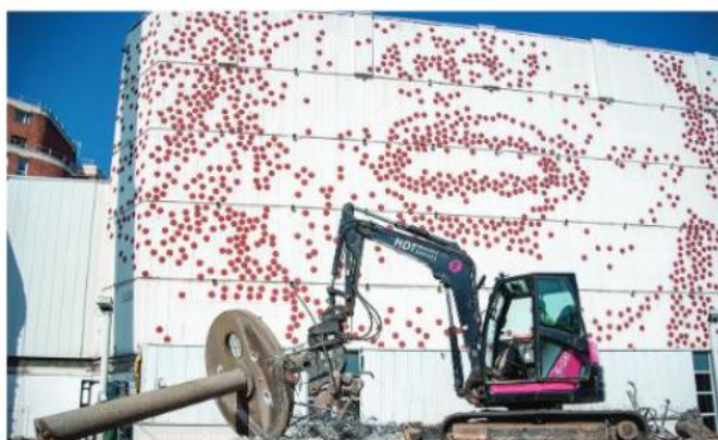
Les travaux de transformation entrent dans « le dur » en cette rentrée.
