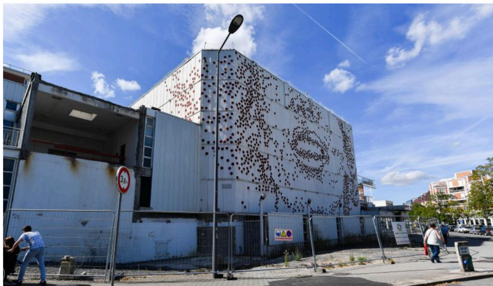
La Rose des Vents est en travaux. - VDNPQR
