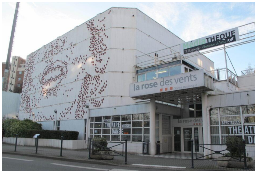
La façade de la Rose des Vents, avant la grande phase de travaux. ©DR
