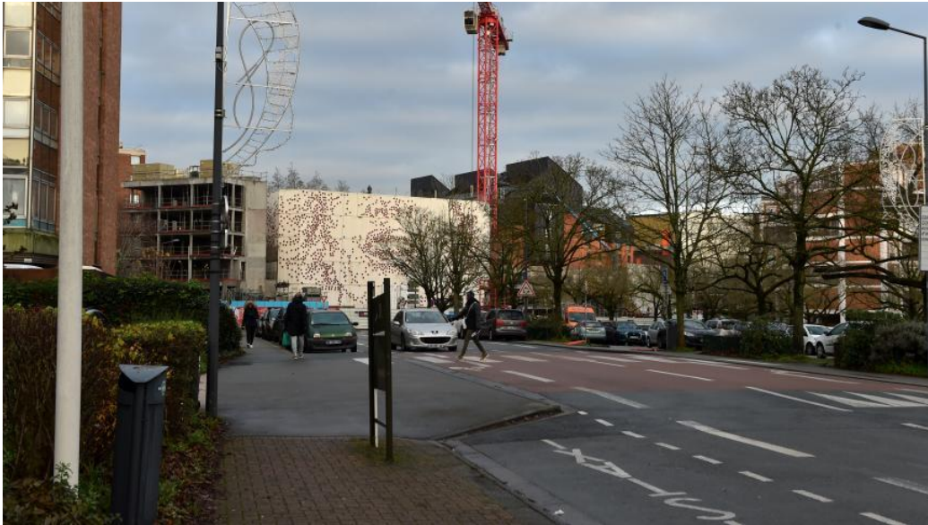
Le chantier de la Rose des Vents se poursuit, et l'aménagement du boulevard Van Gogh se fera dans la foulée. PHOTO ARCHIVES FLORENT MOREAU LA VOIX DU NORD - VDNPQR
